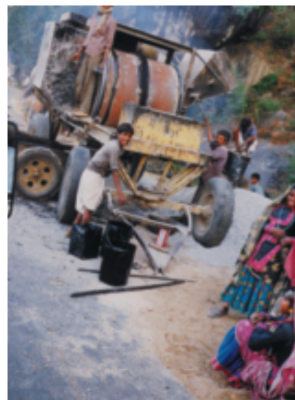
Fig. 2.19 Les ouvriers travaillant au revêtement des routes (ici en Inde) sont exposés aux hydrocarbures aromatiques polycycliques.
