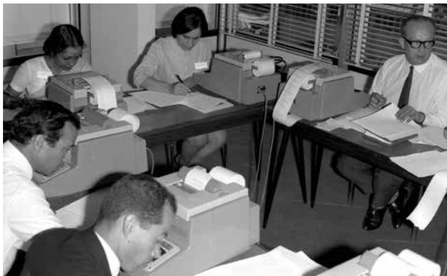
Etudiants travaillant sur des machines à calculer mécaniques, utilisées à la fin des années 1960 pour l'analyse statistique des séries de données épidémiologiques. Outre les quatre opérations arithmétiques, ces machines pouvaient calculer la somme d'une séquence de nombres, ainsi que la somme des produits de deux séquences de nombres.
